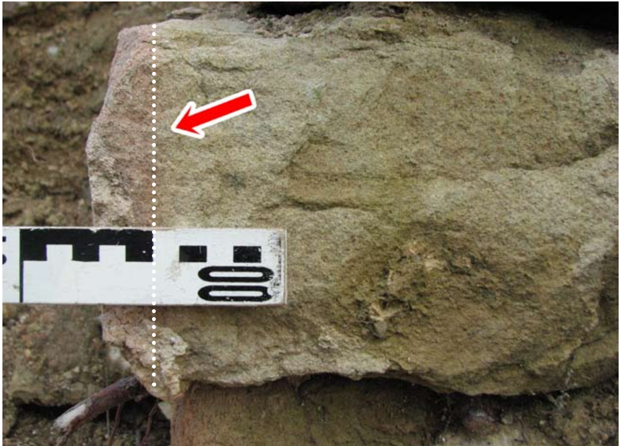
Abb. 13: Burgruine Ried am Riederberg, rechte Portallaibung. Detail der brandgeschädigten Oberfläche der Gewändesteine. – Oliver Fries, 2009.
