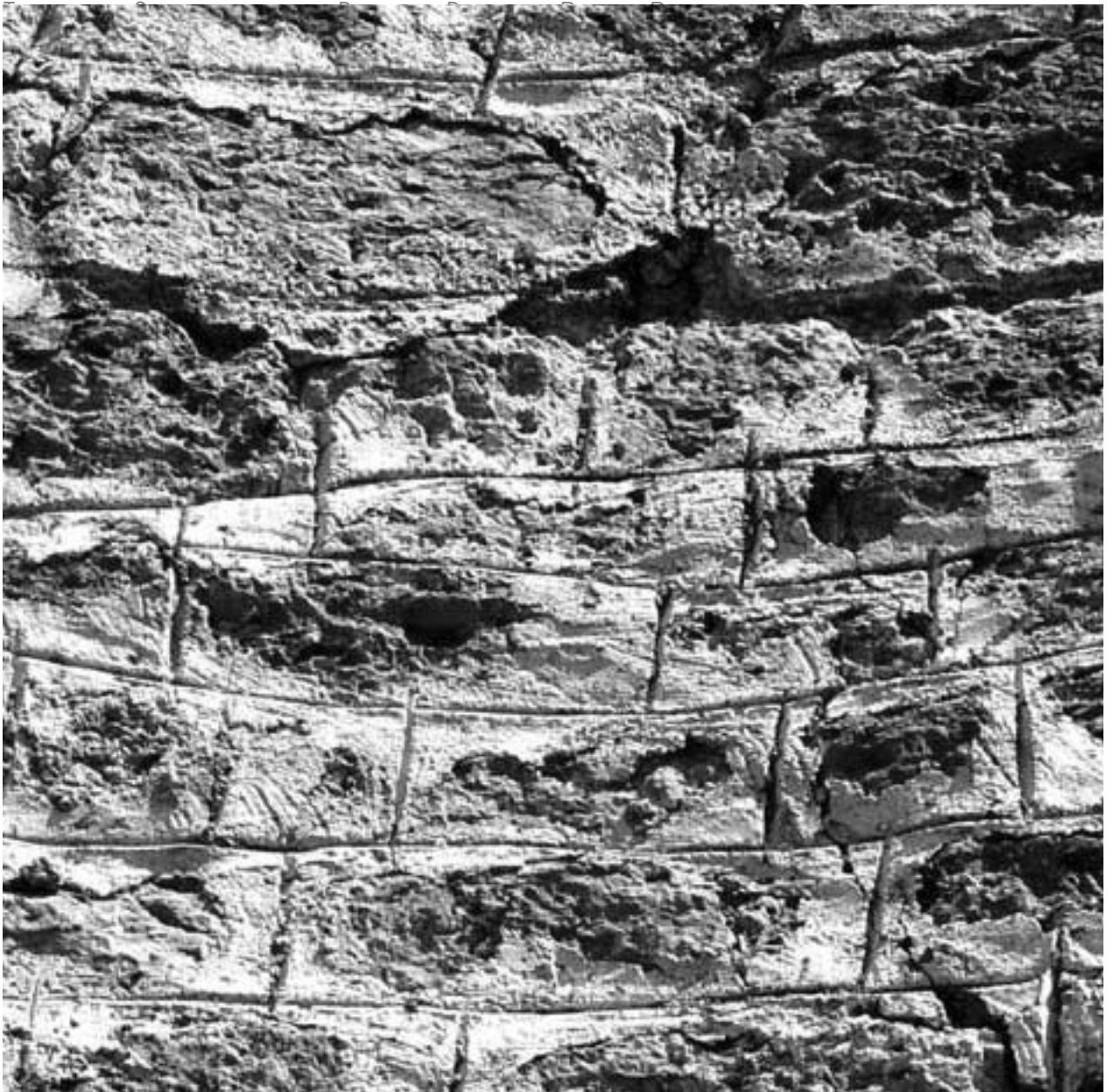
Abb. 10: Burgruine Rabenstein an der Pielach. Detail der pietra rasa -artigen Oberfläche im Inneren des Bergfriedes. Ein vergleichbarer Befund konnte auch in Ried festgestellt werden. – Oliver Fries, 2006.
