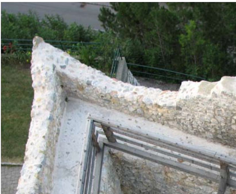
Abb. 20: Burgruine Puchberg am Schneeberg. Aufsicht auf die Kronensicherung des Zinnenkranzes. – Oliver Fries, 2007.
