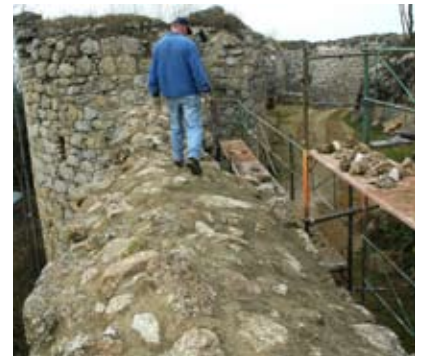
Abb. 19: Burgruine Prandegg (OÖ). Beispiel für die Gestaltung einer Mauerkrone durch Auftragen einer bombierten Verschleißschicht. – BDA, 2008.
